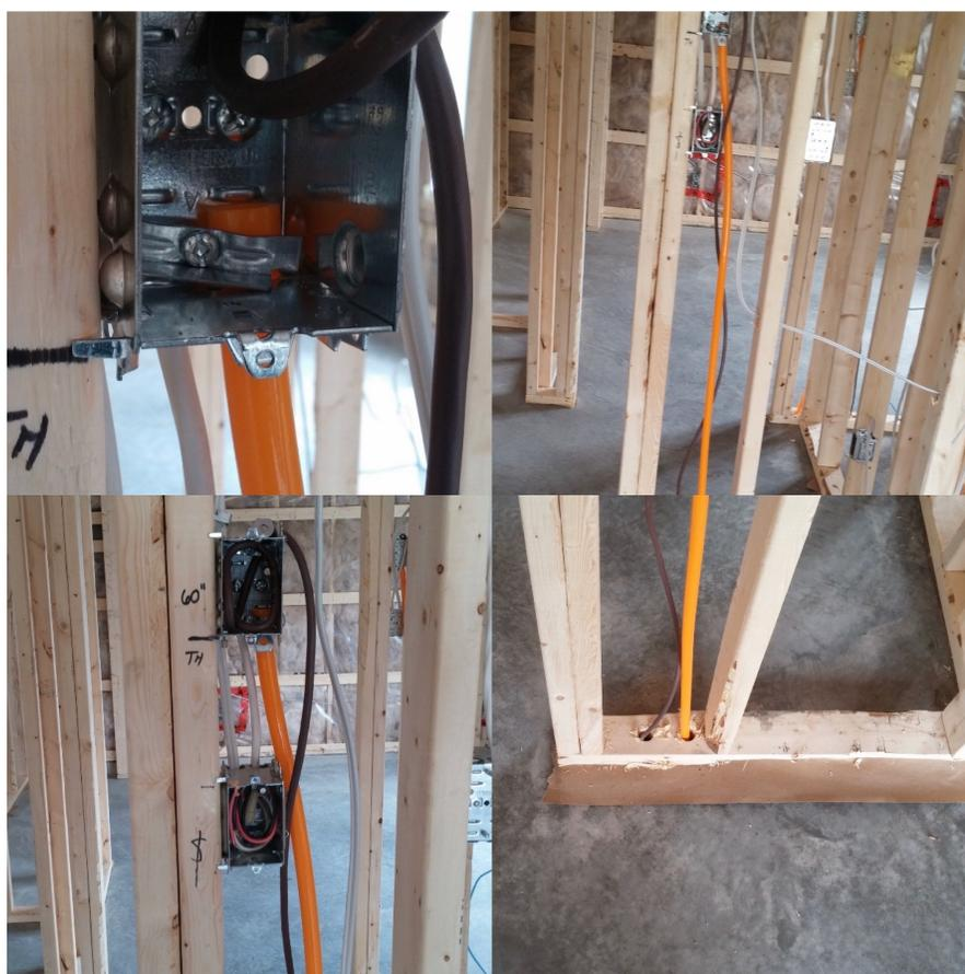
Les thermostats ne devraient pas être installés sur un mur extérieur. Certains installateurs passent un tube vous permettant de faire passer votre fil reliant les thermostats à la chaudière. Ceci vous évitera de devoir passer les fils dans les murs. Ce n'est cependant aucunement une obligation.
