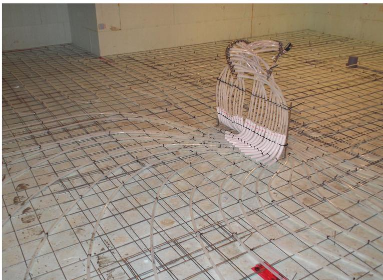
Avant de couler le béton, il faut s'assurer qu'il n'y ait pas de bris des tuyaux qui auraient pu survenir lors de l'installation et ainsi créer une fuite.
