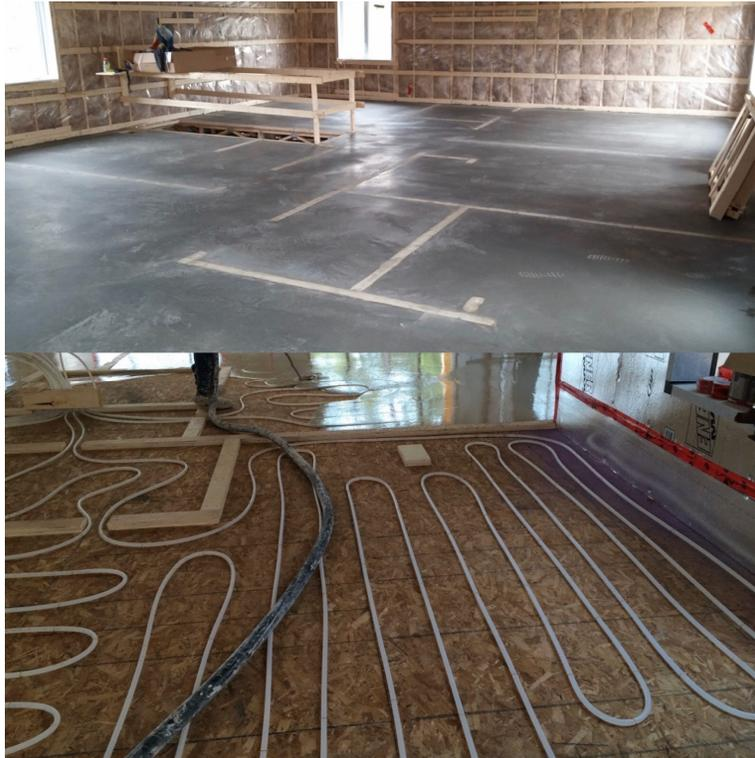
Pour une installation effectuée avec un recouvrement de béton de moins de 2 ½” d'épaisseur, il est recommandé d'y installer préalablement vos lices de murs au sol avant la pose des tuyaux. Prenez soin de ne pas poser les tuyaux à moins de 6” des murs extérieurs et des lices, de manière à éviter des bris au cours de votre construction. Il est moins nécessaire de faire de même lorsque les tuyaux sont enfouis plus profondément mais vous devez rester alerte pour le reste de vos travaux.
