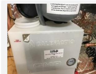
Remplir l'injecteur de liquide jusqu'à la ligne maximum. Le glycol doit être pré-mélangé avec de l'eau avant son introduction.
