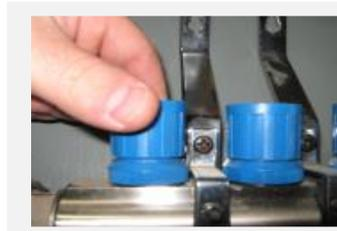
Ouvrir 1 circuit à la fois du collecteur bleu pour la purge durant 15 minutes chacun pour enlever l'air. Une fois terminé, fermer la valve bleue du circuit et répéter l'étape 6 pour les autres circuits.
