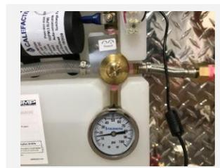
S'assurer qu'à la fin de la purge des circuits, l'injecteur augmente la pression du système à 12-15 psi. Voir sur son cadran. Si la pompe arrête en dessous de 10 psi, augmente la pression sur le régulateur de l'injecteur en suivant le sens de rotation.
