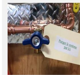
Raccorder un boyau de purge ou mettre une chaudière sur la valve de purge en dessous de la pompe. Remettre le liquide dans l'injecteur.
